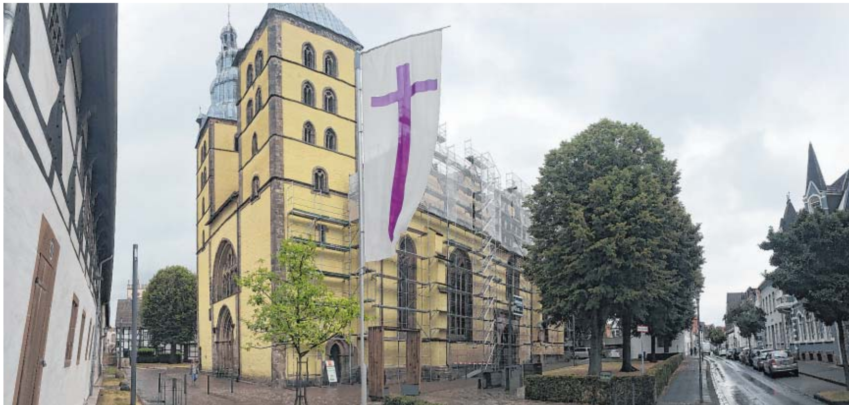
Ein besonderes Ensemble: Mit dem Zeughaus (links), dem sich anschließenden Rathaus und der Bebauung der Papenstraße (rechts) ergibt die Kirche St. Nicolai ein hübsches Fleckchen Lemgoer Erde. Die Südseite des Gotteshauses ist momentan eingerüstet – für Fassaden-, Dach- und Steinmetzarbeiten.
